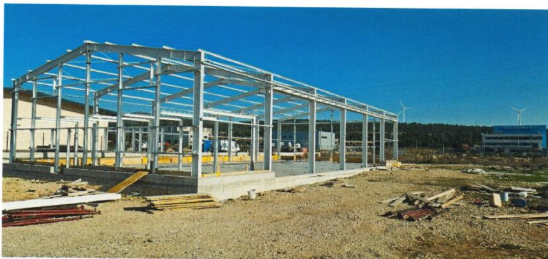
Objekt tvrtke Moto nautika Devčić u izgradnji.
