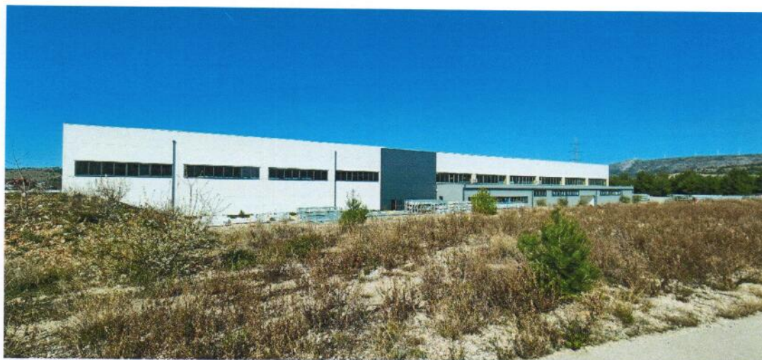
3. objekt 3. tvrtke Skelin Mont d.o.o. u završnoj fazi gradnje.
