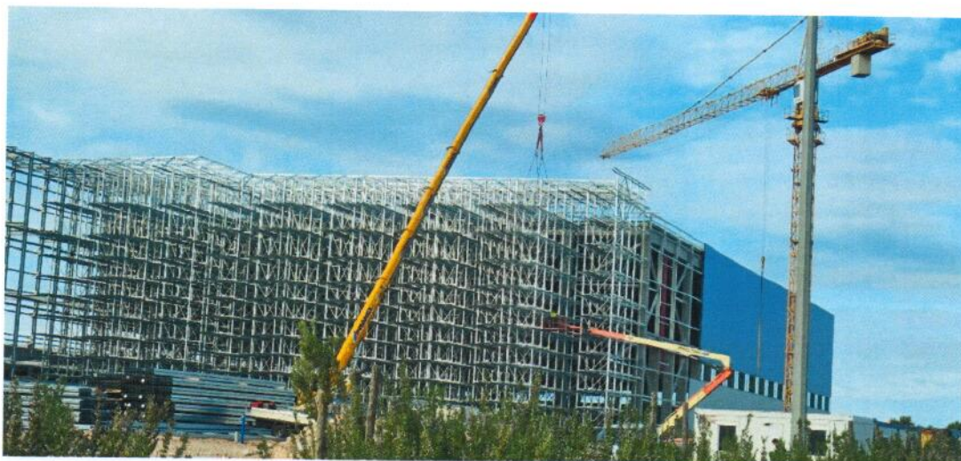
Objekt tvrtke Feroterm d.o.o. u izgradnji.
